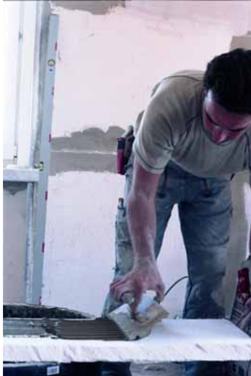
BU: Der MC-Kleber wird mit einem Zahnschachtel vollflächig auf die leichte Platte gekämmt. (Foto: redstone)
