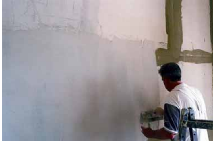
BU: Masterclima-Platten® können bereits nach 24 Stunden verputzt oder tapeziert werden. (Foto: redstone)
