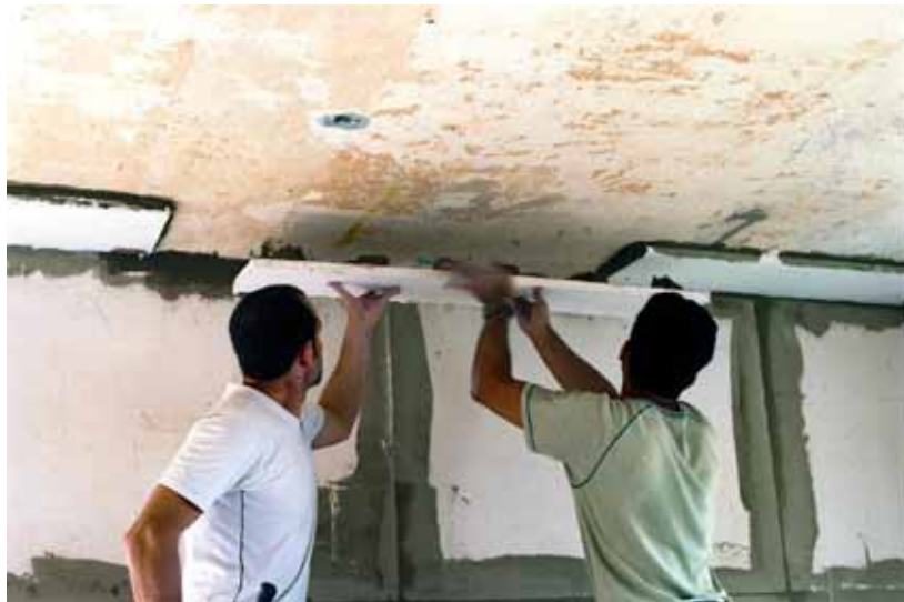
BU: Deckenmontage der Masterclima-Platten®. (Foto: redstone)
