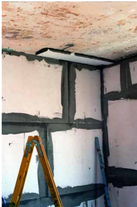
BU: Die Plattenkanten wurden mit MC-Kleber bestrichen. (Foto: redstone)
