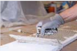
▲ 3. redstone Spezialkleber MC auftragen
