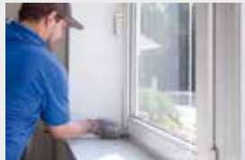
▲ 4. Vivo Laibungsplatte an die Wand anbringen, einschwimmen und dicht stoßen
