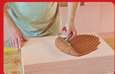
3. ... und auf die Platte auftragen
