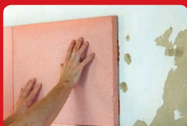
4. Pura dur ansetzen, einschwimmen
