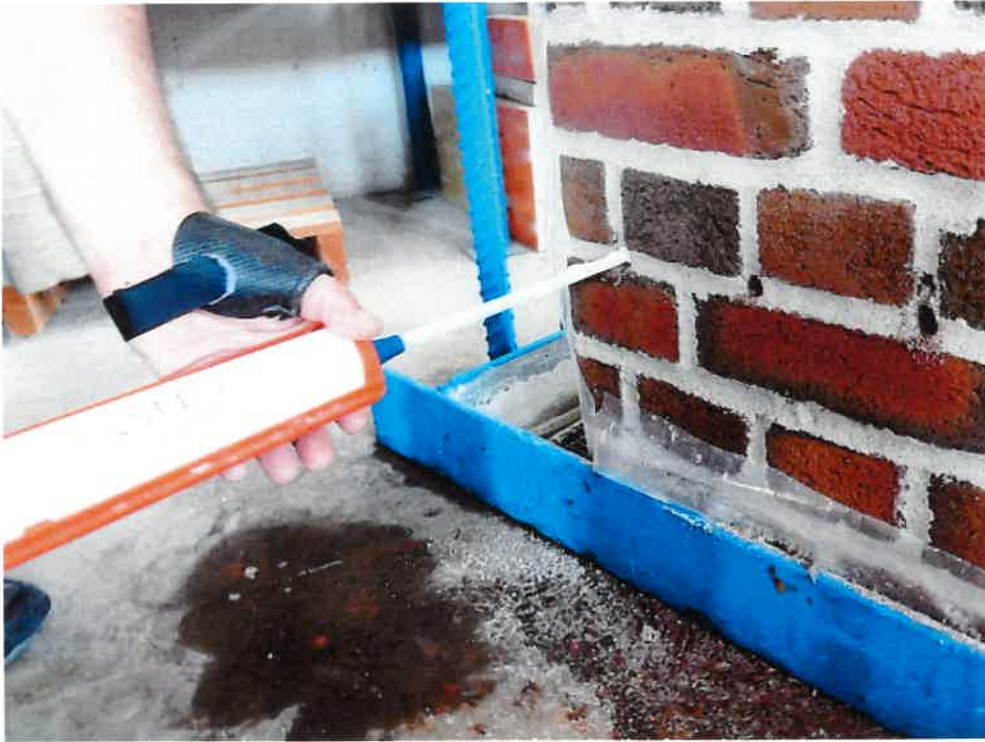
Bild 3 Injektion der Secco Horizontalsperre
