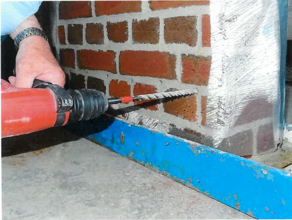
Bild 1 Anlegen der Bohrungen
