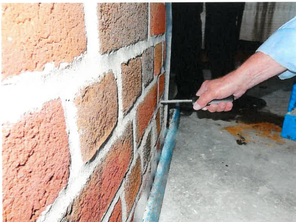
Bild 2 Reinigung der Bohrlöcher
