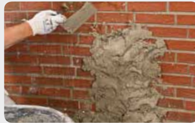
2. Sperrputz: Sperrputz aufbringen...
