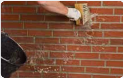
1. Grundieren: trockene Untergründe ausreichend vornässen, Grundierung FS sättigend auftragen (500–750 ml/m 2 )
